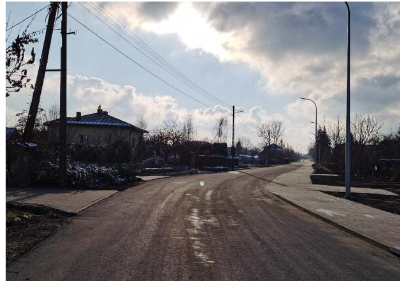
9. Wykonanie nawierzchni asfaltowej na ul. Kolejowej w Niedzwicy Dużej.
