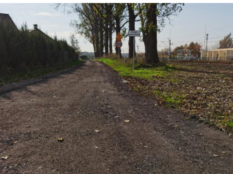
12. Wykonanie z destruktu asfaltowego nawierzchni drogi w Niedzwicy Dużej ul. Sosnowa.
