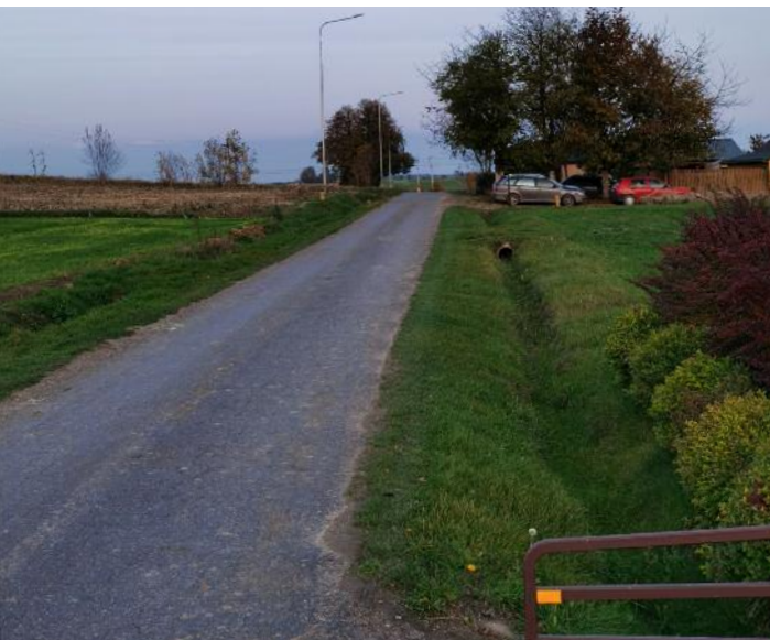
4. Wykonanie oświetlenia drogowego w Majdanie Sobieszczańskim.
