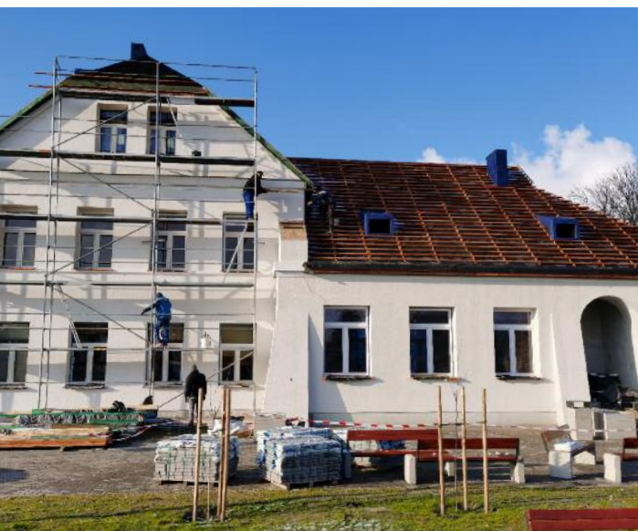
7. Trwa przebudowa budynku dawnego dworca PKP w Niedzwicy Dużej – obecnie wymieniana jest część konstrukcji oraz pokrycie dachu. Wewnątrz budynku prowadzone są prace remontowe w części publicznej i mieszkalnej.
