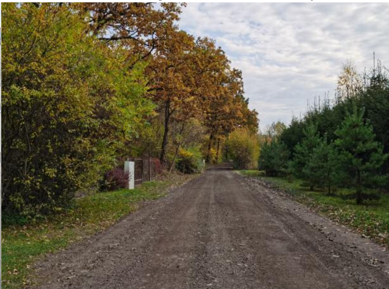
10. Wykonanie z destruktu asfaltowego nawierzchni drogi w Strzeszkowicach Dużych.
