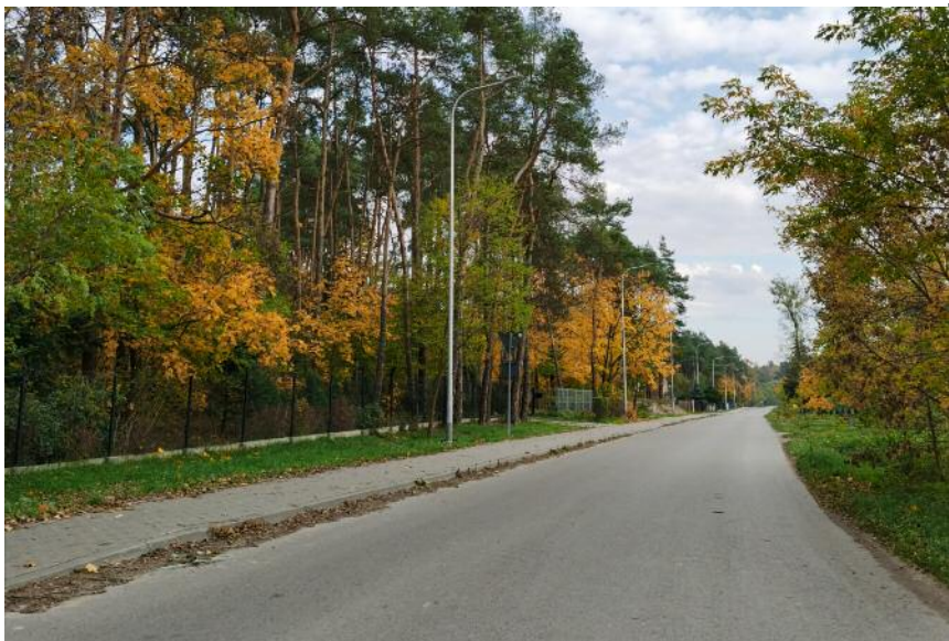
6. Trwa rozbudowa oczyszczalni ścieków w Niedzwicy Dużej.
