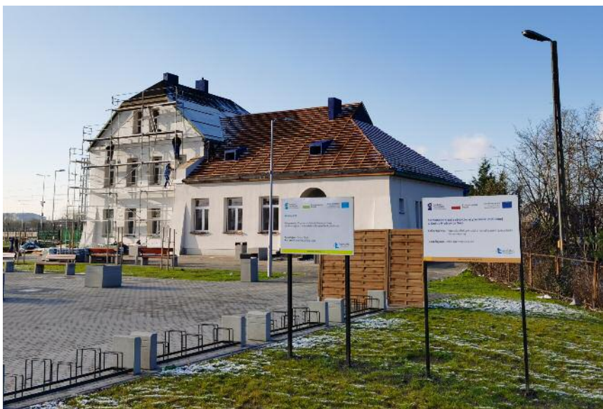
7. Trwa przebudowa budynku dawnego dworca PKP w Niedzwicy Dużej – obecnie wymieniana jest część konstrukcji oraz pokrycie dachu. Wewnątrz budynku prowadzone są prace remontowe w części publicznej i mieszkalnej.
