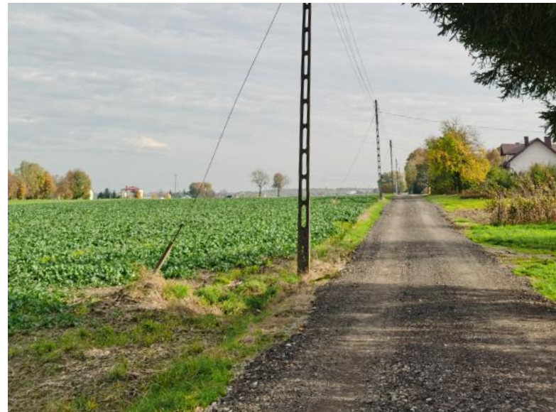
11. Wykonanie z destruktu asfaltowego nawierzchni drogi w Strzeszkowicach Dużych tzw. Grabówka.
