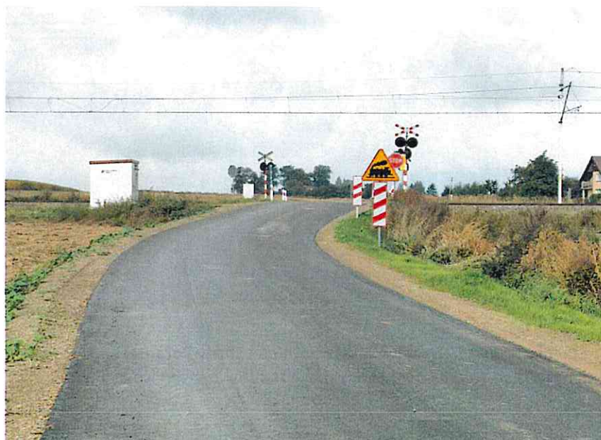
Przebudowa drogi gminnej w Krężnicy Jarej pomiędzy drogą powiatową a torami kolejowymi
