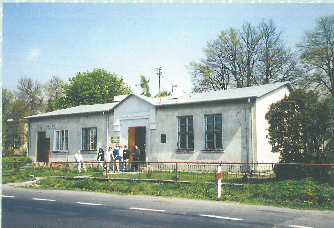
Dom Ludowy – siedziba Społecznego Liceum Ogólnokształcącego w Niedzwicy Kościelnej
